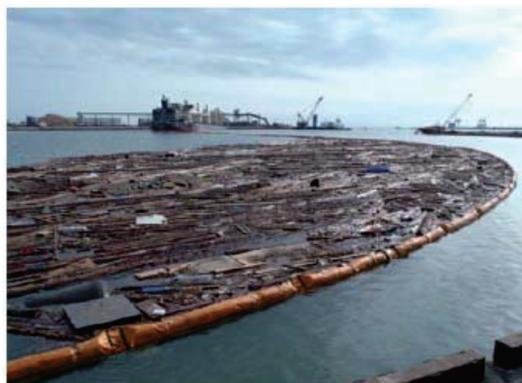
図—1 シルプロによる浮遊障害物の封じ込め状況<sup>1)</sup>
